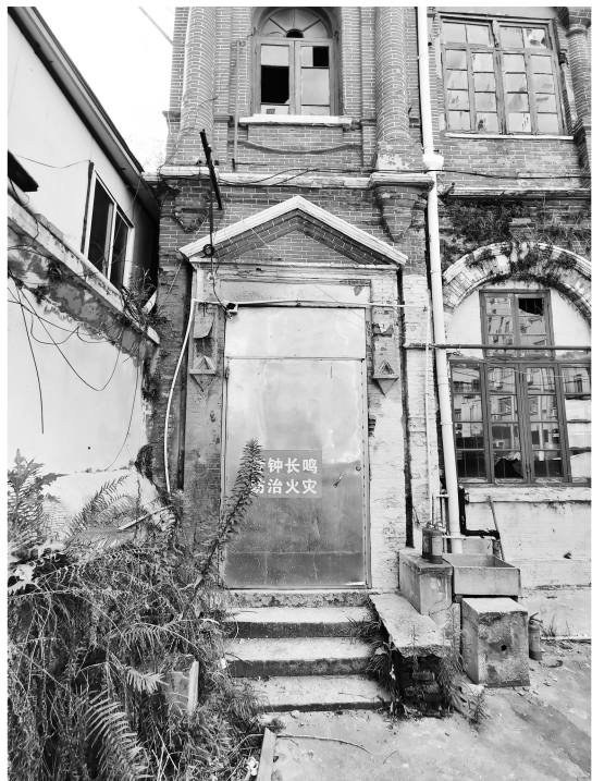
图2 唐绍仪全家合影处门厅现状，所存结构与历史照片一致（笔者摄）
